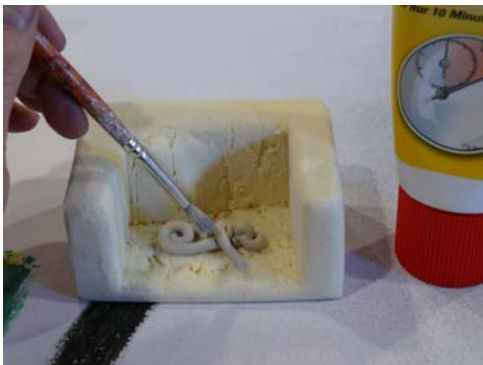
Zuerst etwas Spachtelmasse auf die Fläche geben, dann mit einem Pinsel und reichlich Wasser verteilen.
